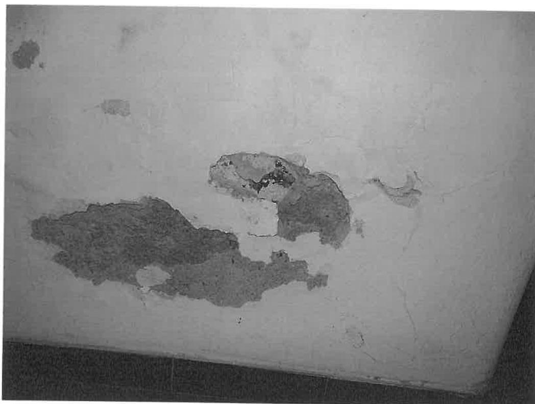
Fot.16 Zasolenia i zawilgocenia ścian w zakrystii
