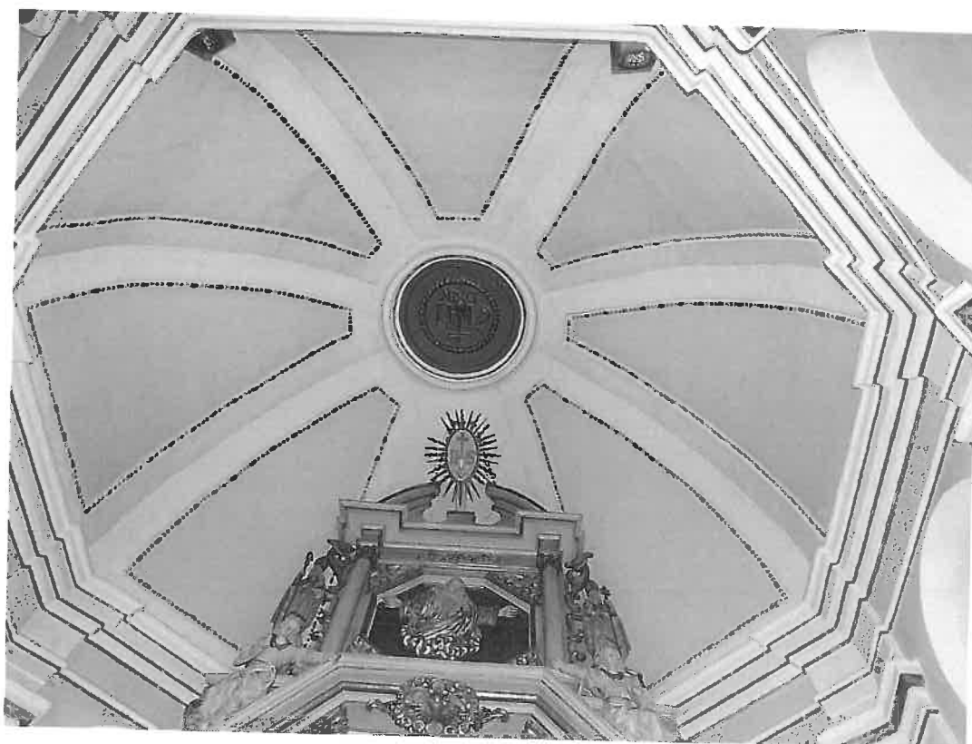
Fot. 31 Kopuła kaplicy z miejscowymi pęknięciami i śladami po zaciekach
