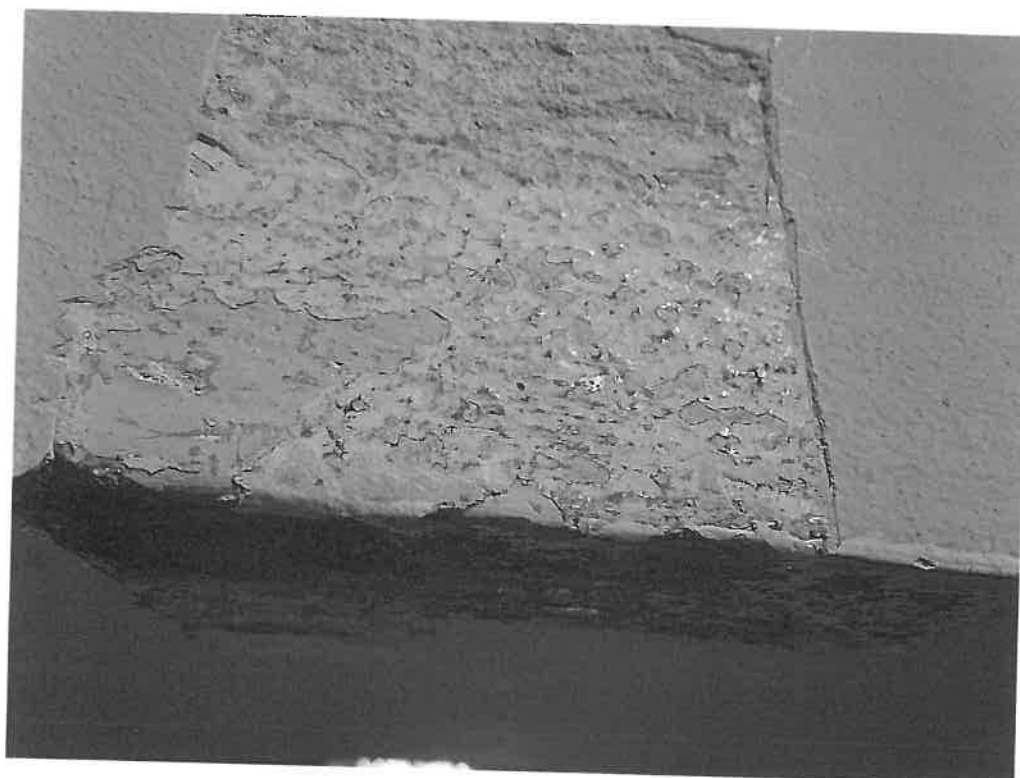
Fot. 66 Odkrywka nr 22 Odkrywka na ścianie wschodniej nawy przy łuku tęczowym z widoczną pozłotą
