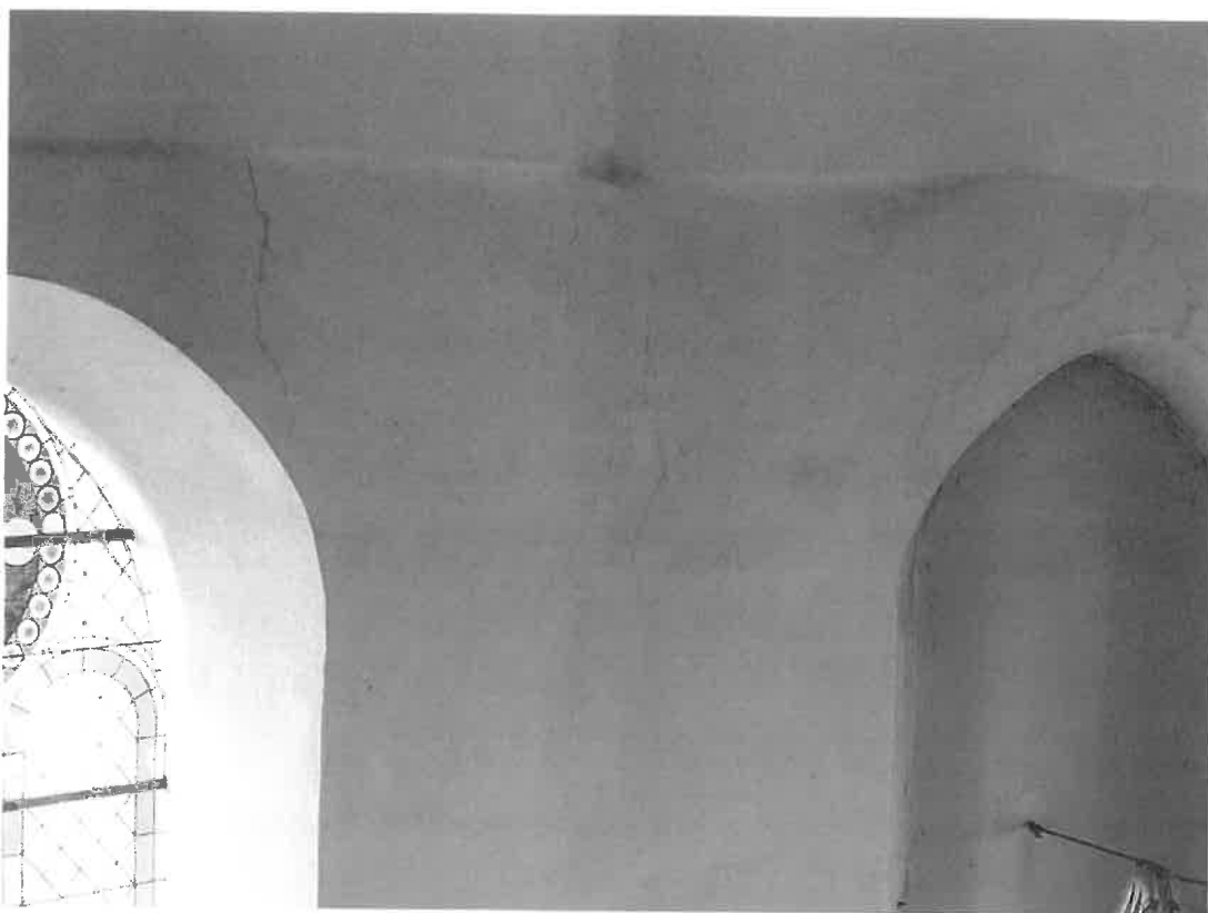
Fot. 20 Włoskowate pęknięcia w górnej części ścian
