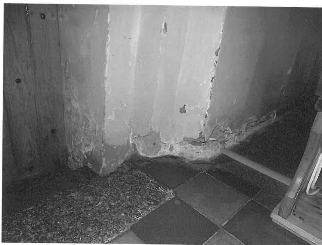
Fot. 14 Zły stan techniczny dolnych partii ścian prezbiterium, z widocznymi rozwarstwieniami powierzchni malarskich.
