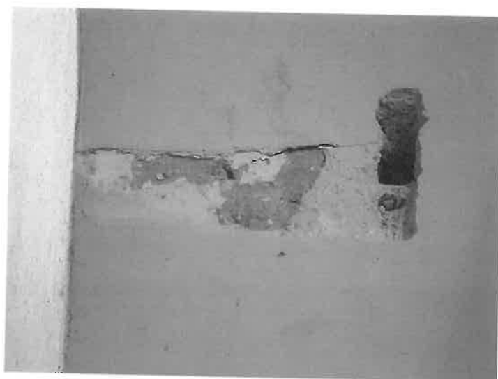
Fot. 67 Odkrywka nr 23 Odkrywka na ścianie południowej nawy
