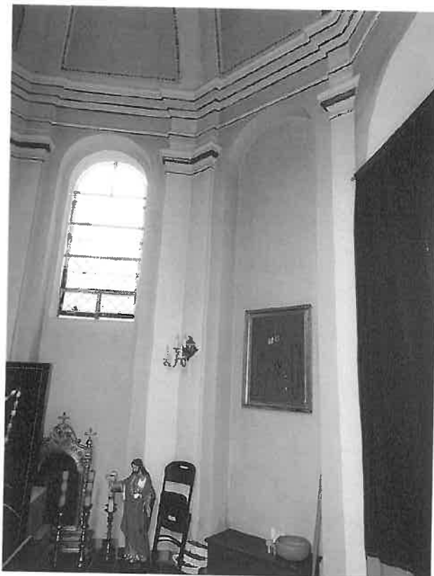
Fot. 32 Miejsce zawilgocenia ścian kaplicy oraz zaoksydowany złożony detal architektoniczny
