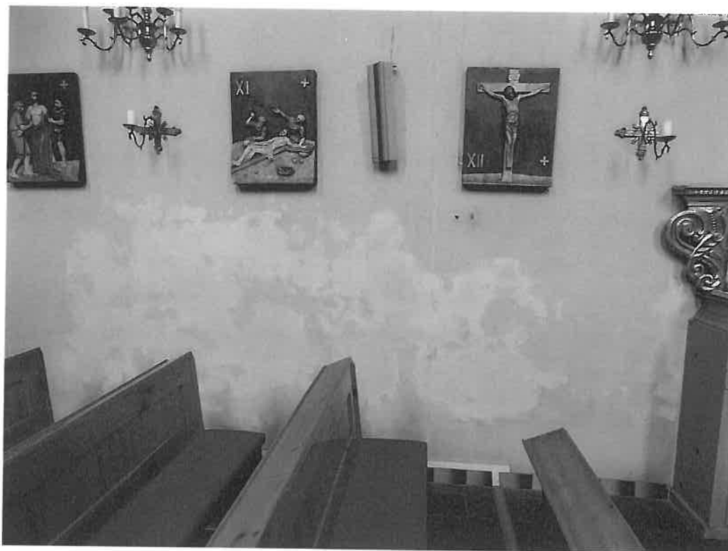
Fot. 11 Zły stan techniczny dolnych partii ścian po stronie północnej.
