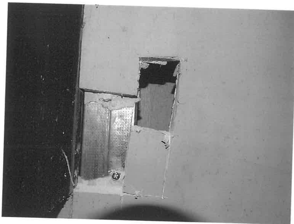
Fot. 59 Odkrywka nr 18 Odkrywka na ścianie północnej prezbiterium – płyta gipsowo – kartonowa na stelażu, maskująca uskok (odsadzkę) w głębokości ściany około 15 cm
