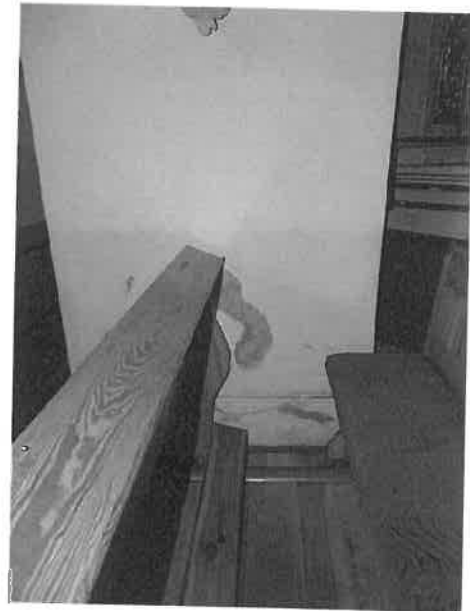
Fot. 18,19 Zasolenia i zawilgocenia ścian w przyziemiu łuku tęczowego
