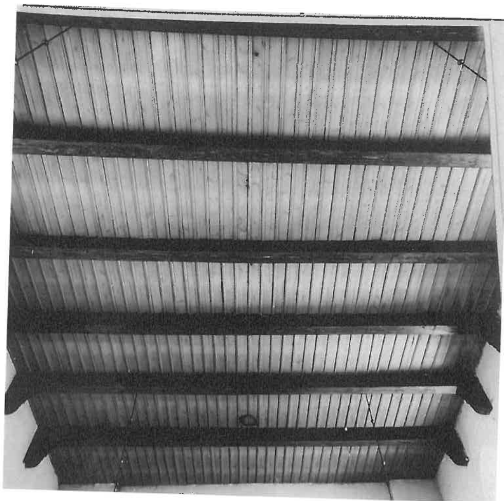
Fot. 34 Wygląd stropu deskowo – listwowego w nawie kościoła
