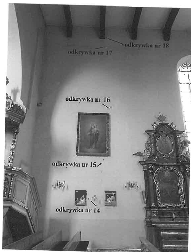
Fot. 60 Lokalizacja odkrywek na ścianie północnej prezbiterium
