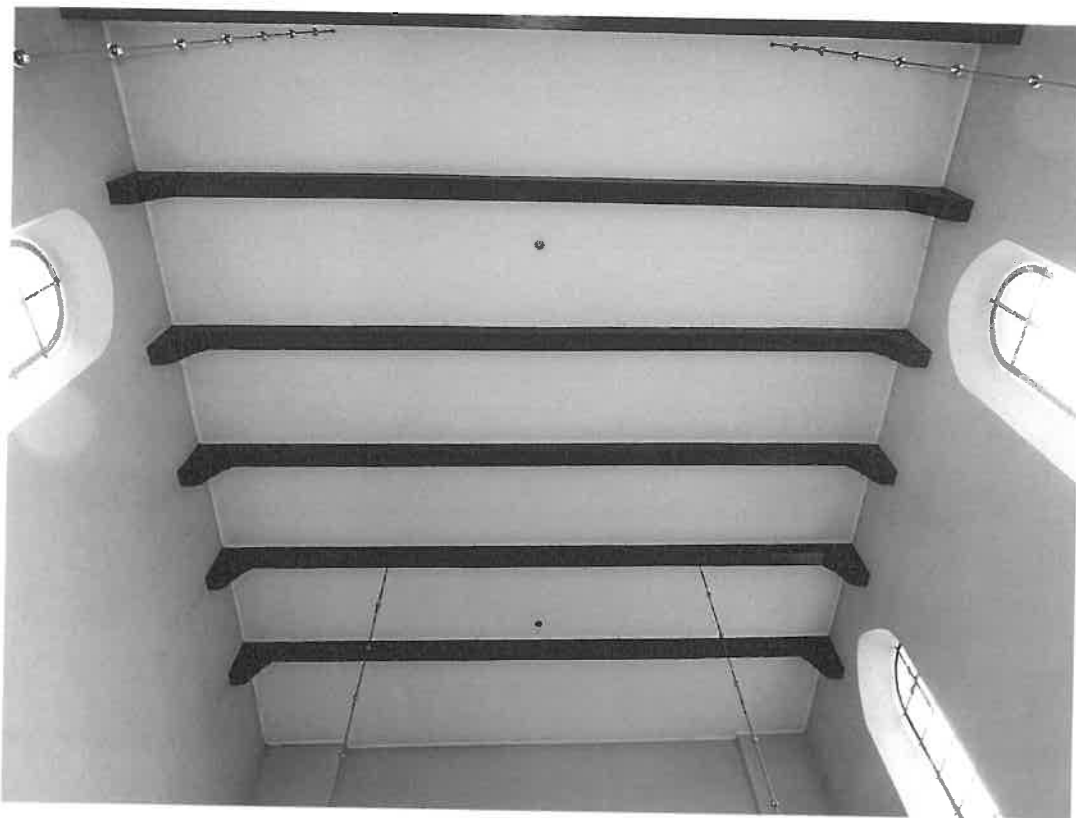
Fot. 28 Pola międzybelkowe wypełnione płytą gipsowo – kartonową w części nawy
